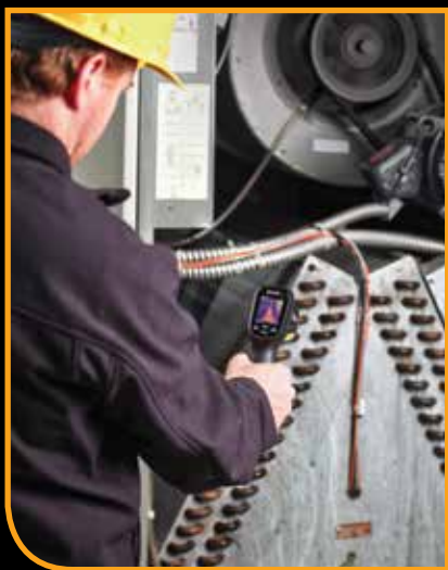
Ispezioni di sistemi di condizionamento (HVAC)
