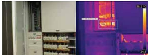
Anche se questi terminali di uscita sono certamente caldi, le temperature misurate sono normali per un carico di questo tipo.
