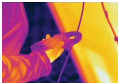
La quantità di elettricità prodotta dal pannello può essere misurata facilmente con la pinza amperometrica. I dati delle misurazioni vengono combinati con l'immagine termografica, con l'aiuto della tecnologia FLIR MeterLink.
