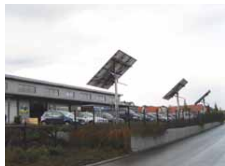
Questi pannelli solari, montati su pali, possono essere analizzati dal retro per ridurre al minimo i riflessi.
