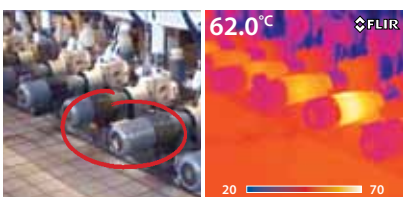
Verifica di un motore elettrico con la termocamera FLIR Serie E.
