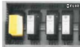
Immagine FLIR Thermal Fusion di un interruttore di circuito surriscaldato.
