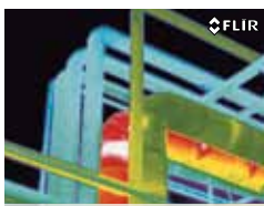
Cedimento dell'isolamento
