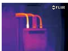
Collegamento difettoso e danneggiamento interno
