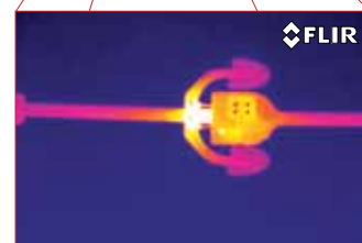
L'immagine ad infrarossi di un impianto ad alta tensione ripresa da una certa distanza consente comunque di rilevare tutti i dettagli, garantendo una maggiore sicurezza sul lavoro.
